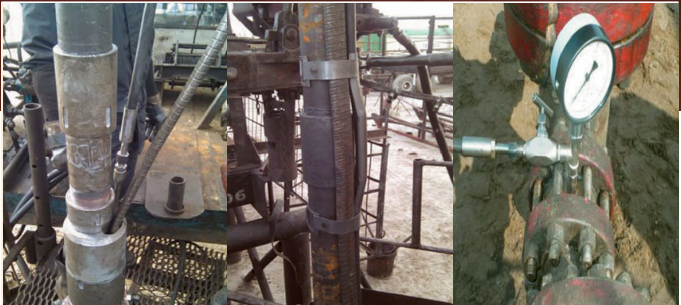
Рис. 2. Монтаж пакера с кабельным вводом и импульсной трубки
